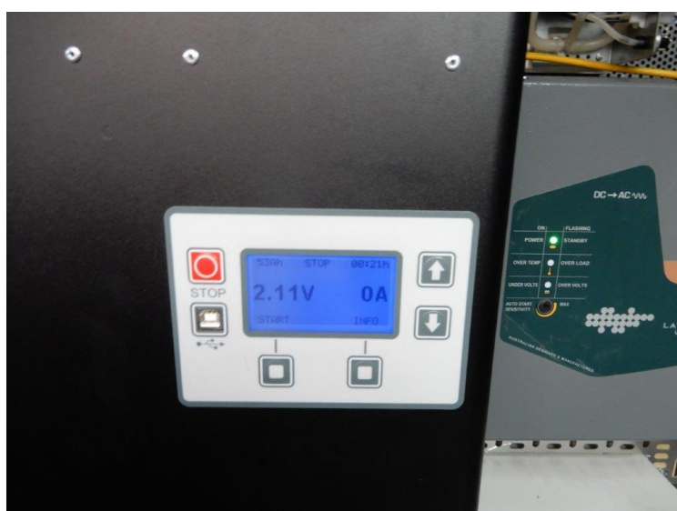
Acculader behorende bij de Bellmarine installatie
