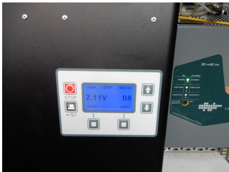
Acculader behorende bij de Bellmarine installatie
